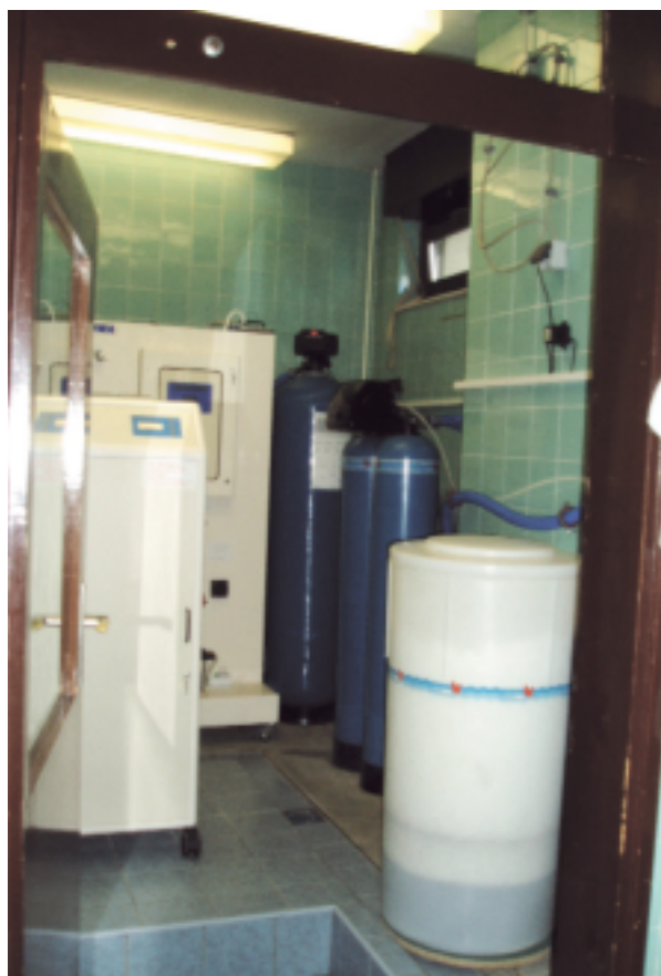
Slika 21. Stanica za pripremu demineralizirane vode s termičkom dezinfekcijom
